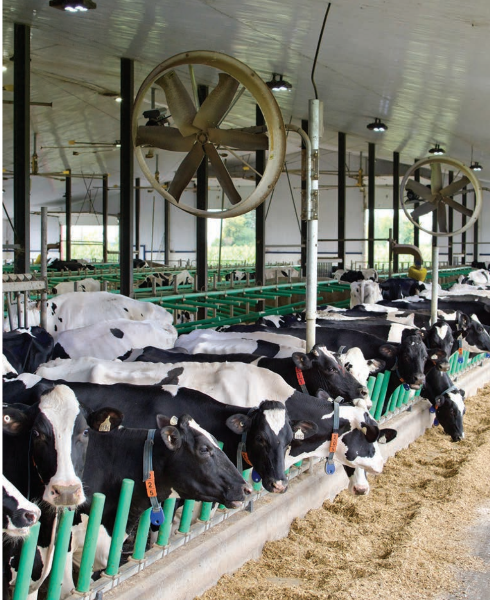
Les ventilateurs de recirculation sont populaires. Selon Lactanet, 95 % des producteurs qui ont ajouté une option de refroidissement au système de ventilation de leur étable ont choisi des ventilateurs de recirculation.
