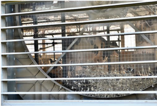
Sébastien Fournel signale qu'un ventilateur sale peut perdre jusqu'à 24 % de son efficacité.
