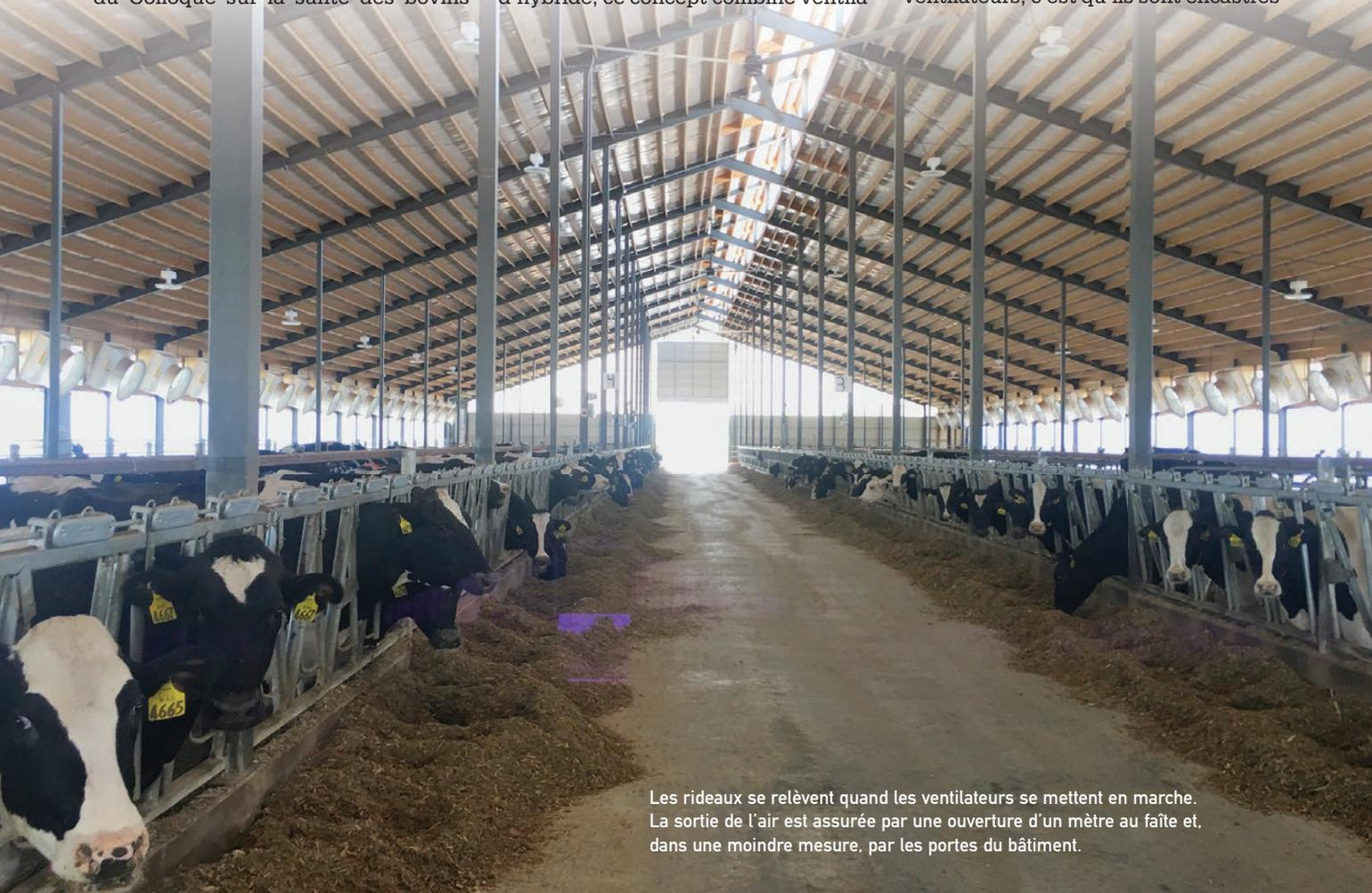
Les rideaux se relèvent quand les ventilateurs se mettent en marche. La sortie de l'air est assurée par une ouverture d'un mètre au faite et, dans une moindre mesure, par les portes du bâtiment.
