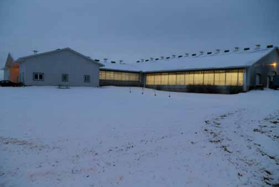
Les installations de la Ferme SCH ont été agrandies en 2013.
